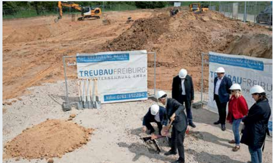
Eine kupferne Zeitkapsel, die eine Tageszeitung, Kleingeld und Pläne enthält, wurde von Volker Homann zusammen mit Bürgermeister Martin Löffler in die künftige Bodenplatte eingemauert.
